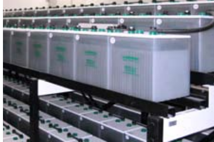
Wartungsarme, geschlossene Blockbatterien
